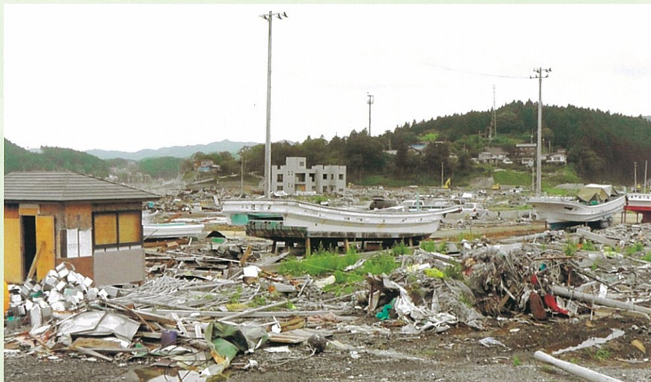
【宮城県南三陸町志津川の被災状況】
