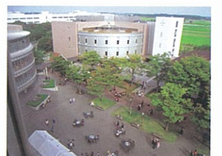
14号館(12号館6階より10月撮影)
